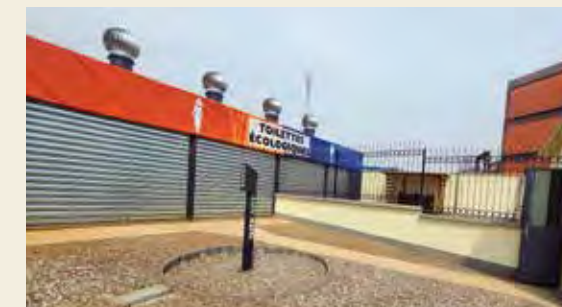
Toilettes éco-responsables à fortes fréquentations, centre-ville Yaoundé, Cameroun 2021
